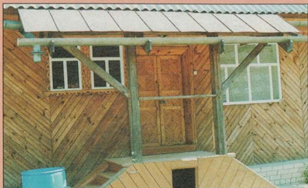
С такими водоотливами крыльцо всегда сухое. Над дверью хозяин трудился не один день
